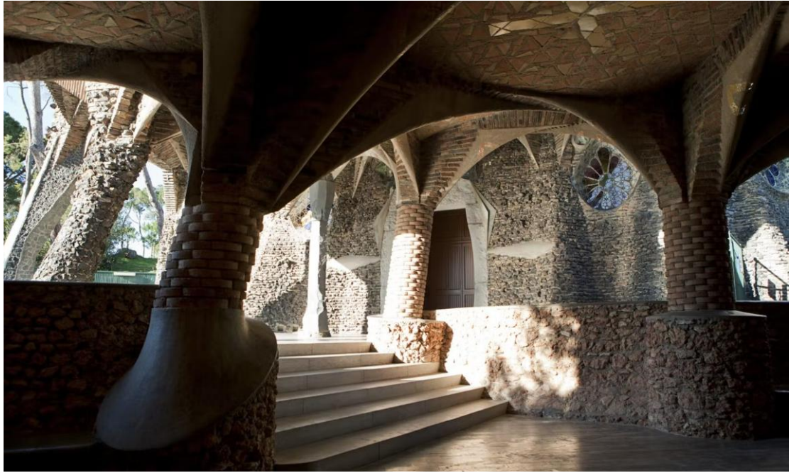
[Fig. 2] Crypte de la Colonia Güell: Vues des colonnes du portique de l'église.
