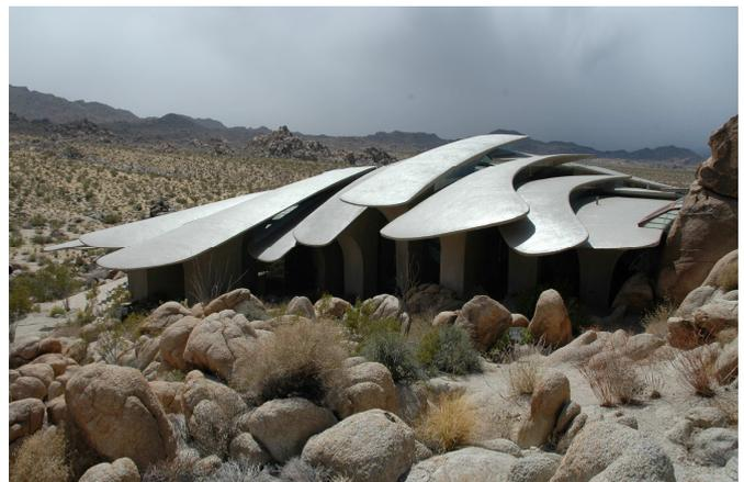
moignage, il n'a été utilisé, pour la construction des formes rondes de la maison, que la moitié de la quantité de béton qui eût été nécessaire aux besoins d'une maison rectangulaire de même surface. De plus, la maison étant enfouie dans le sol, le chauffage aussi bien que la climatisation furent inutiles. La température intérieure, été comme hiver, est étonnement stable (autour de 18°C).
